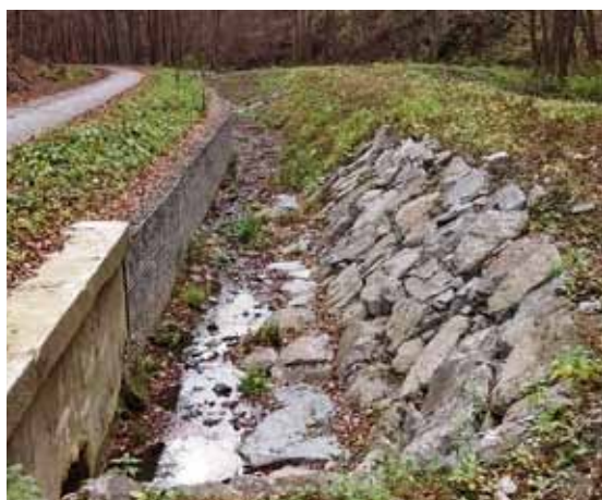
Preventivní protipovodňová opatření na vodním toku Malá Haná, divize Plumlov
