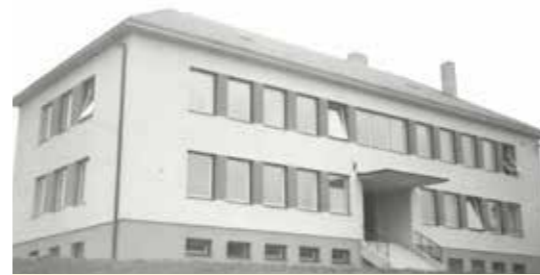
Budova PŘ VL Plumlov, 1967
