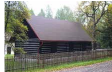
Hájovna Krejčovka během rekonstrukce, rok 2005
