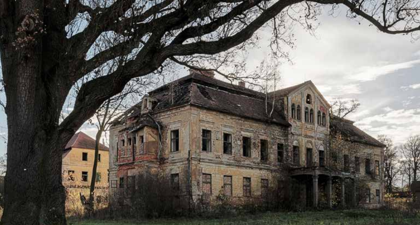
Zámecký areál ve Vintřově, kde původně sídlila zemědělská správa VLS, po restitucích stále chátrá.
