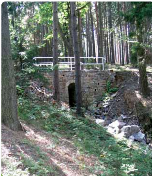
Rekonstrukce mostku na lesní cestě Felbabka - Podluhy (Lesní správa Jince)
