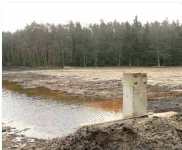
Revitalizace Hradčanských rybníků – obnova rybníka Strážovský (divize Mimoň)
