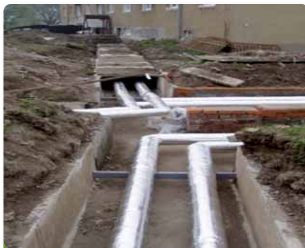
Rekonstrukce topných kanálů v osadě Bražec (útvar nepotřebného majetku)
