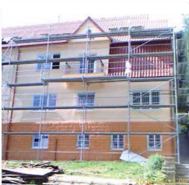
Stavební úpravy budovy ředitelství divize Karlovy Vary
