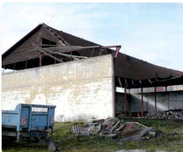
Demolice objektu seníku – zemědělská správa Bražec (útvar zemědělské výroby)
