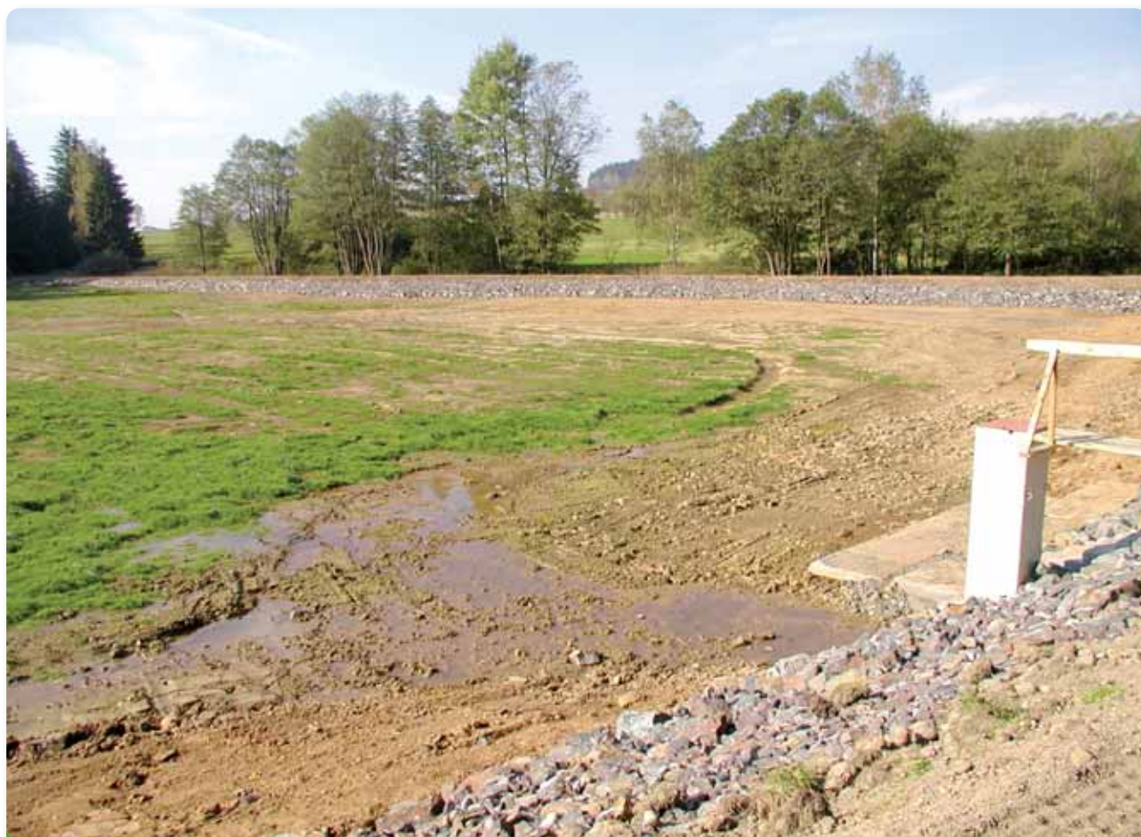
Rekonstrukce a odbahnění rybníka Nový (divize Hořovice)
